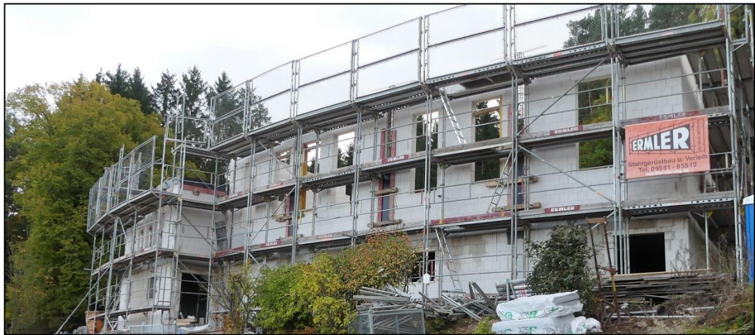
Ansicht des Kindernest-Gebäudes im Winter 2021
